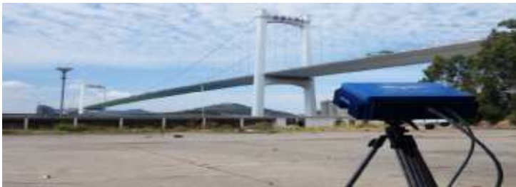
Figura 8: Puente de la Autopista en observación.
