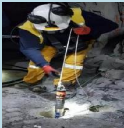
Descenso de la prima dentro del pozo
